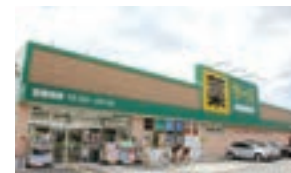
川西丸の内店(兵庫県川西市)
